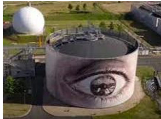
Digesteur anaérobie et réservoir à biogaz (STEU Seine amont à Valenton)
