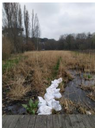
Mars 2021 (travaux d'étanchéité entre les deux filtres)
