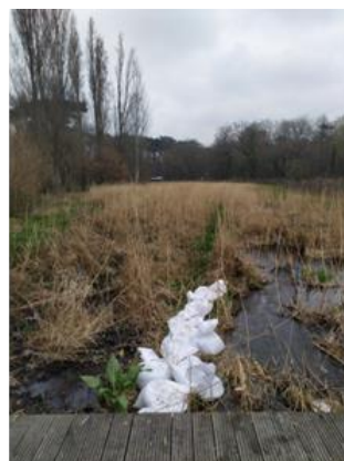
Mars 2021 (travaux d'étanchéité entre les deux filtres)
